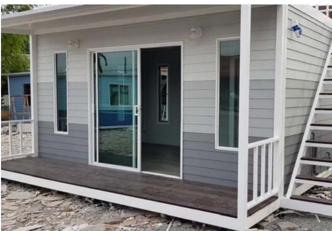
บ้านประกอบเสร็จ
